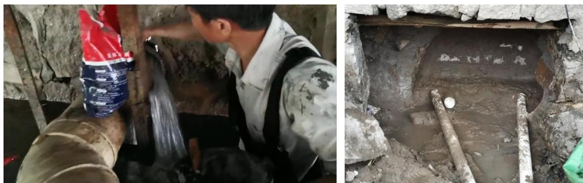
图 5.5-3 现场工作人员紧急维修封堵
