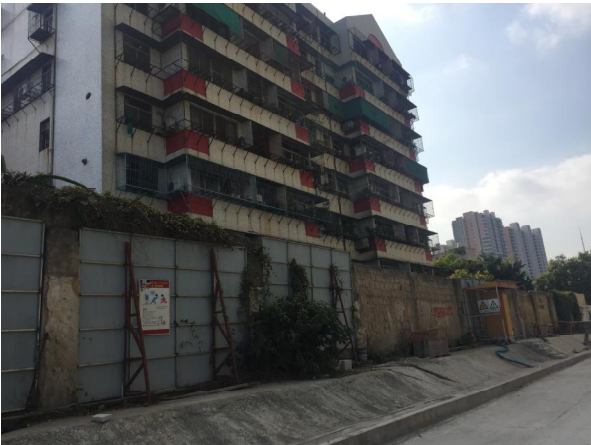
图 1.3.3-4 沿线建筑现状
