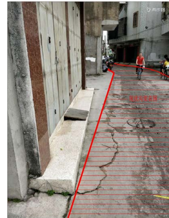
现状沟渠位置
