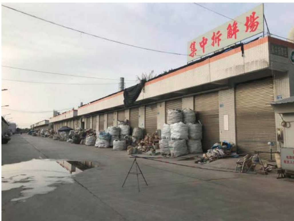
集中拆解楼一期现状图 1
