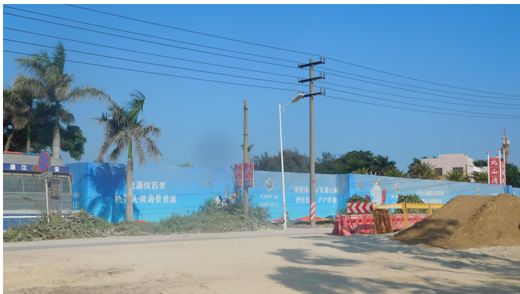
图 4-10 北山湾污水泵站现状图
