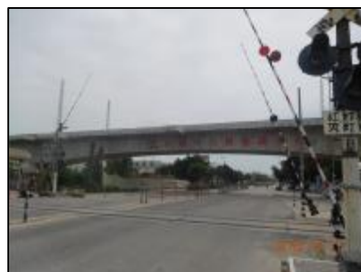
新建高铁高架桥
