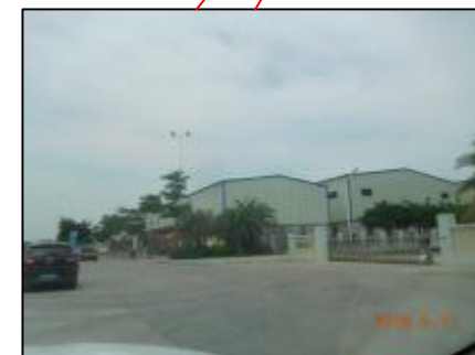
新津水厂大门口
