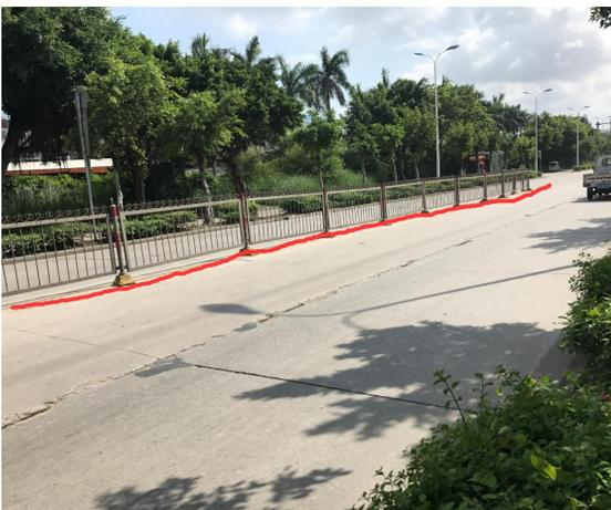
左图为汕樟北路（泰山路-下埠桥西）现状乙型护栏陈旧，本次设计更换乙型护栏。
