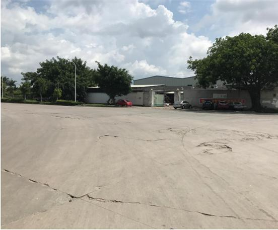
左图为汕樟北路（泰山路-下埠桥西）现状局部混凝土路面开裂、破损严重，对现状混凝土板块开裂、破损严重的板块破除并新建混凝土板块，板块尺寸按现状。
