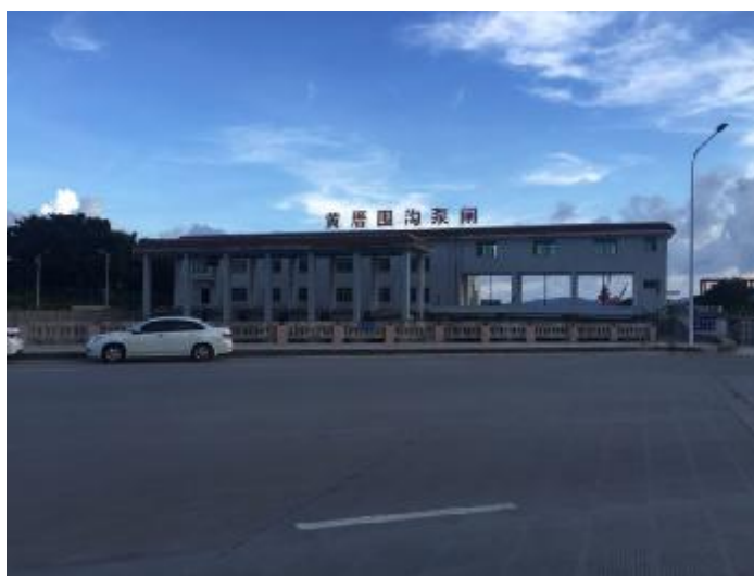
现状黄厝围沟泵闸
