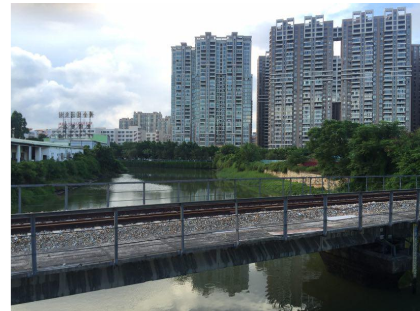
现状港区排洪沟照片
