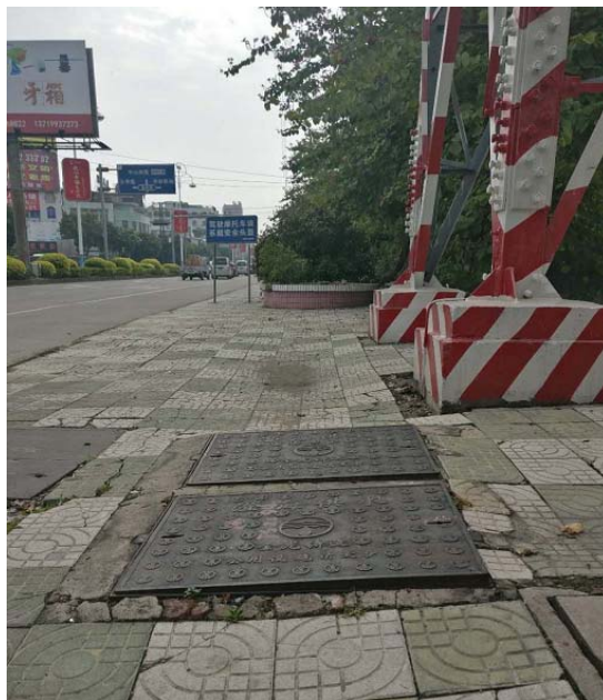
现状市政道路给水管道
