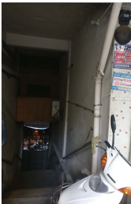
现状明设管道
