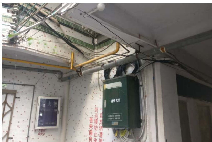
现状管道吊管
