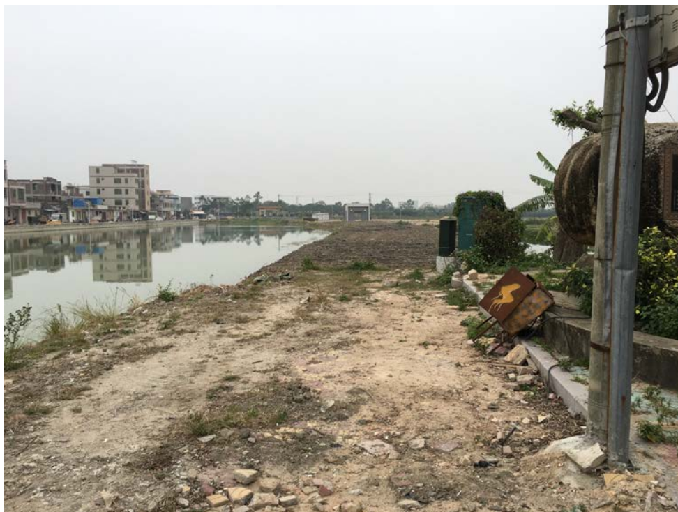
堤脚园休闲长廊现场图
