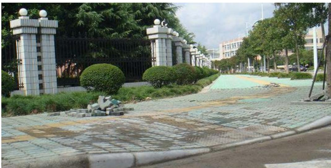
所有路口均采用无障碍设计，缘石坡道一般采用单面坡缘石坡道，型式根据设置地点选择方形、长方形或扇形，坡道下口宽度一般大于 2m，坡比小于等于 1:20，高出车行道的地面小于 1cm。
