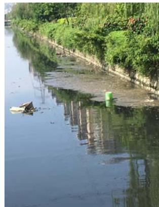
因此，本项目建议对导流渠和南排渠进行全线清淤，总长度约 14.38km。其中，导流渠（登峰路单孔闸~莱美路秀水桥段）长度约
