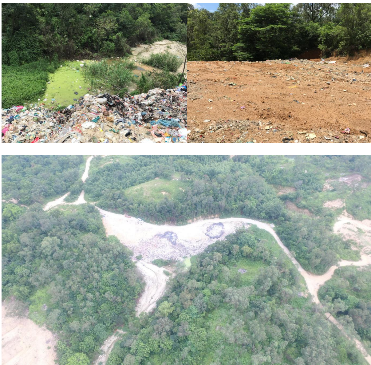
图 2-9 仙城镇简易垃圾填埋场现状
