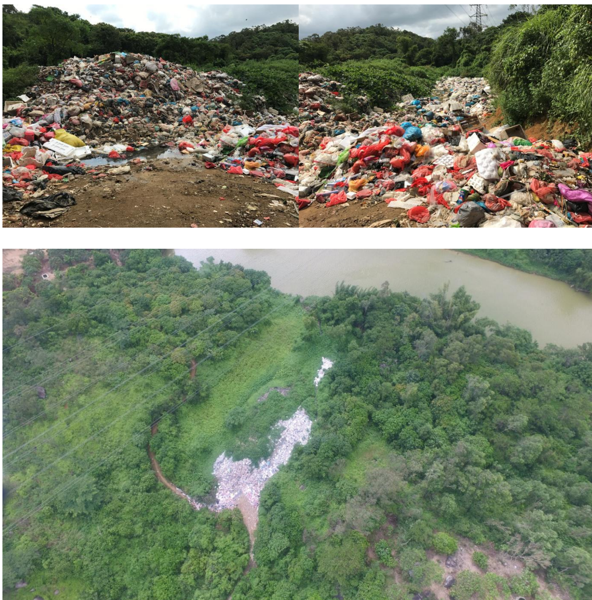
图 2-11 雷岭镇简易垃圾填埋场现状
