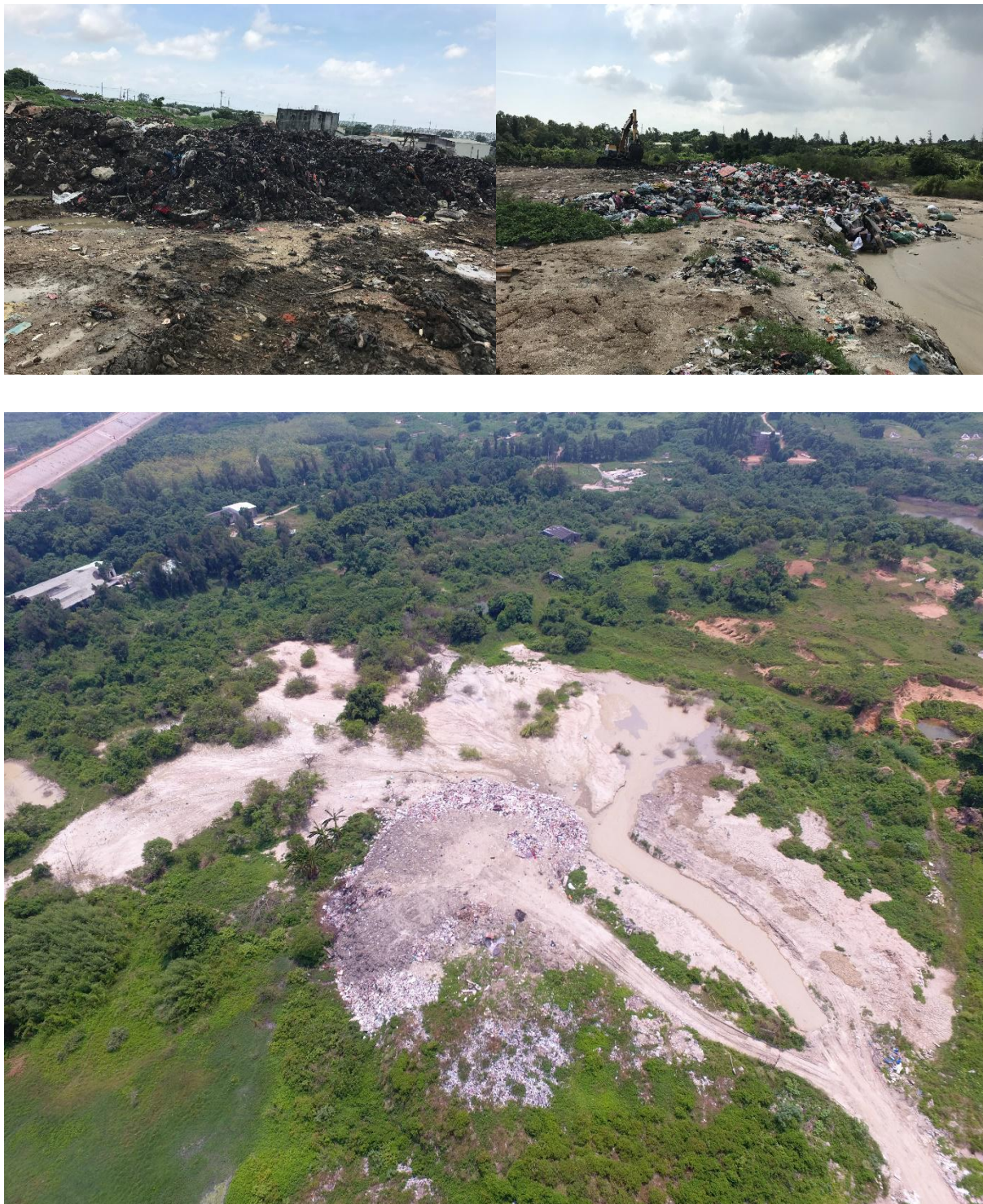
图 2-7 胪岗镇简易垃圾填埋场现状
