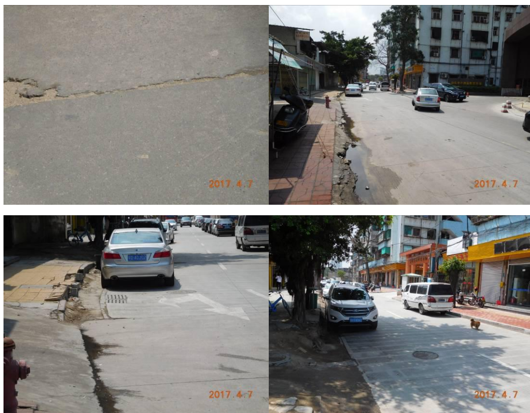
图 3-10 第八区段现状
