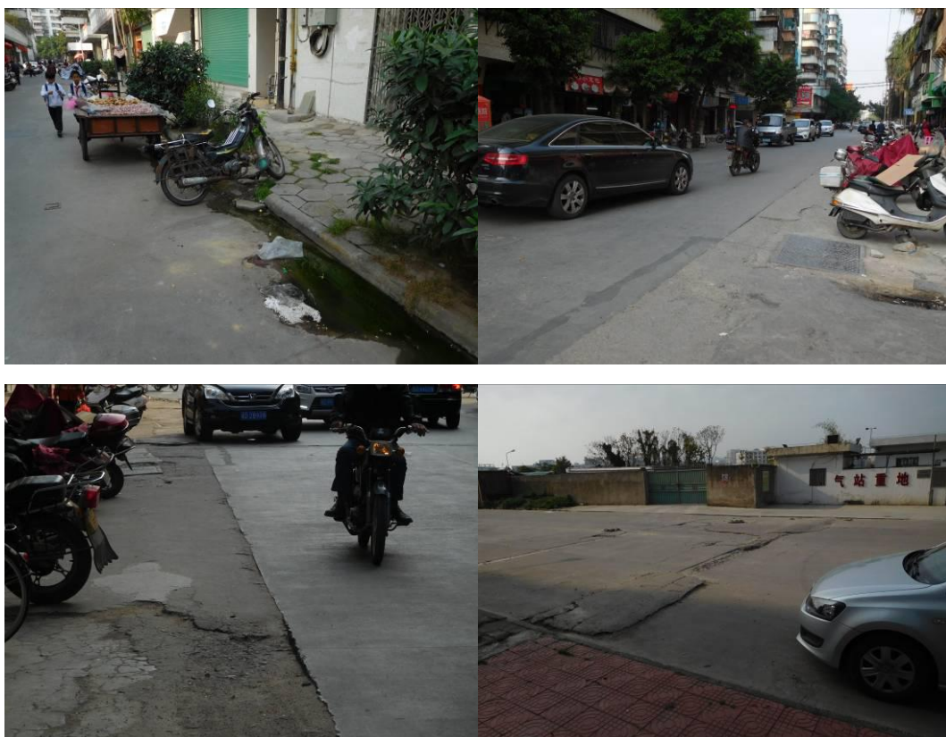
图 3-11 第九区段现状
