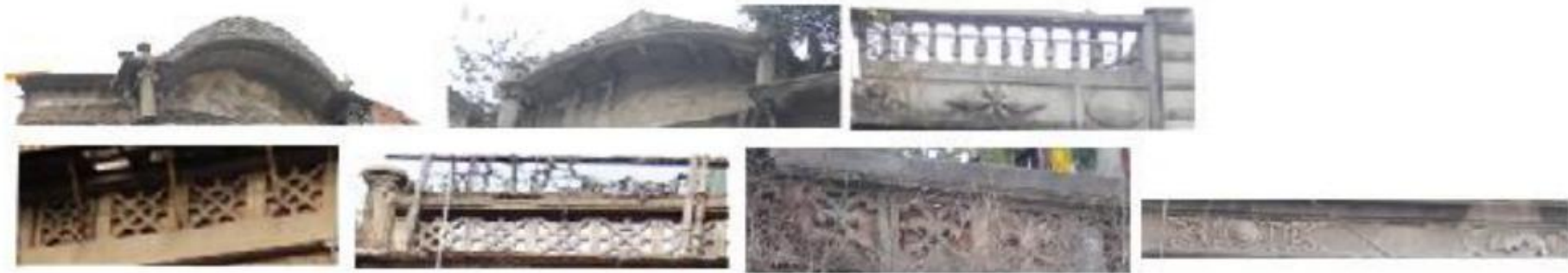
图 4-13 本项目建筑屋檐及顶部现状图
