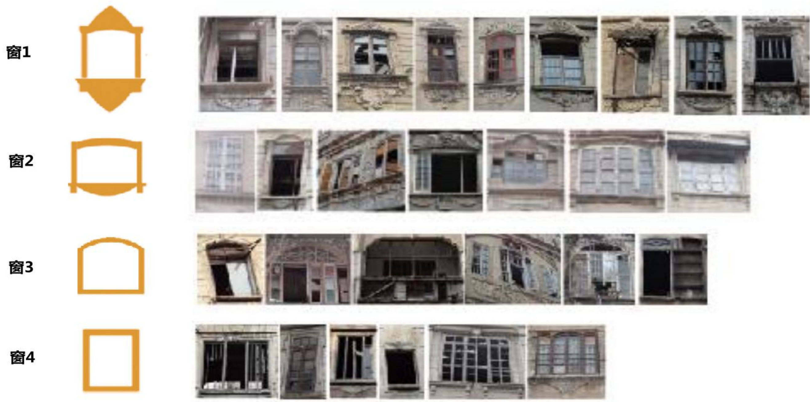
图 4-11 本项目建筑窗现状图
