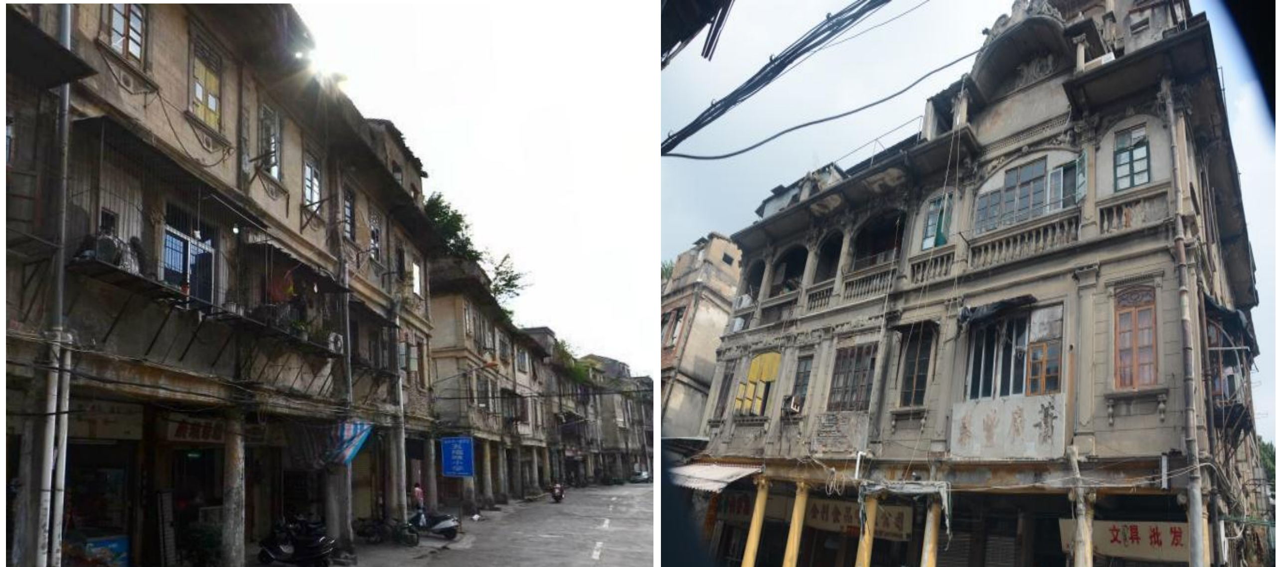
图 4-6 本项目建筑现状图（三类建筑）
