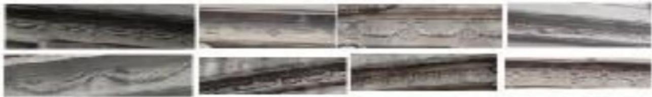
图 4-14 本项目建筑凹槽纹饰线现状图
