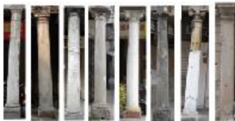
图 4-16 本项目建筑廊柱现状图
