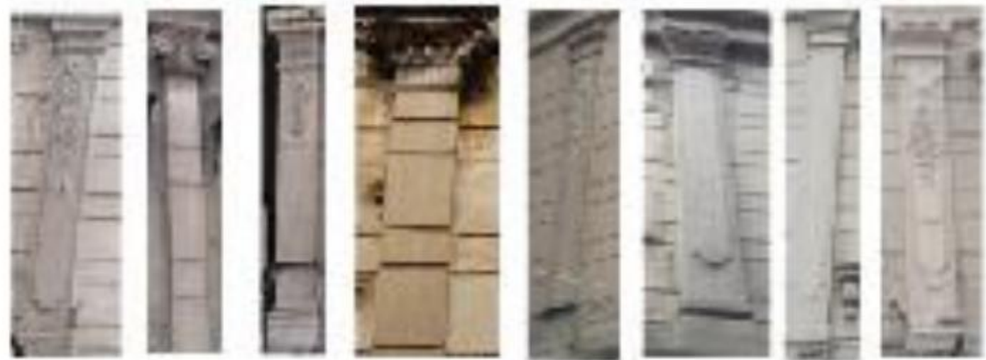
图 4-15 本项目建筑壁柱现状图
