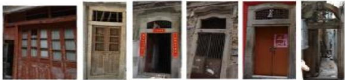
图 4-12 本项目建筑门现状图
