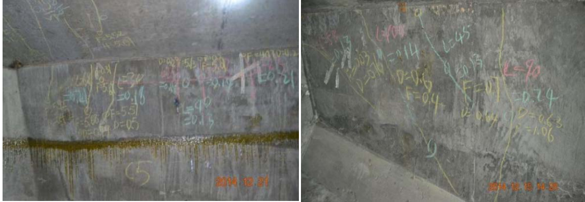
b) 横隔板裂缝
