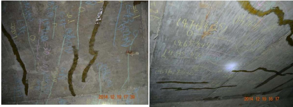
b) 横隔板裂缝
