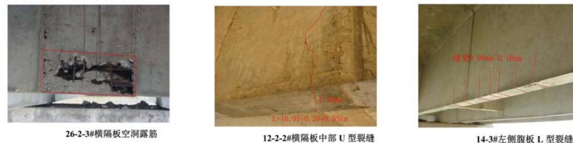
26-2-3#横隔板空洞露筋
