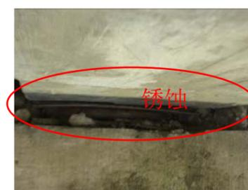
支座老化、上钢板锈蚀
