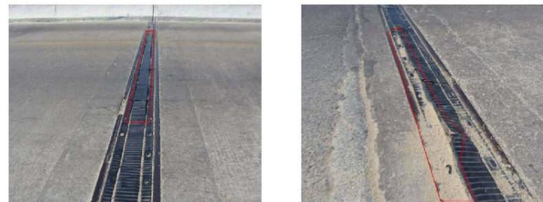
6#伸缩缝橡胶条破损
