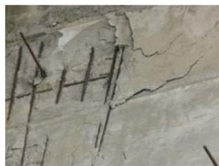
18#墩盖梁锈胀露筋
