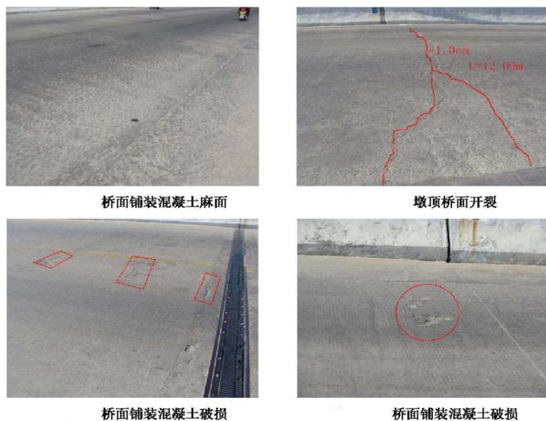
桥面铺装混凝土麻面
