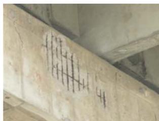
20#墩盖梁锈胀露筋
