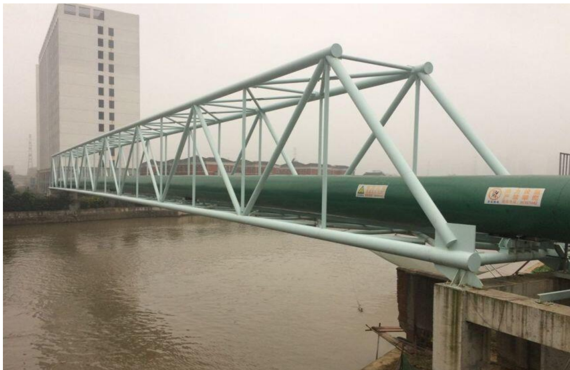
(管道采取桁架方式跨越河道实例图)
