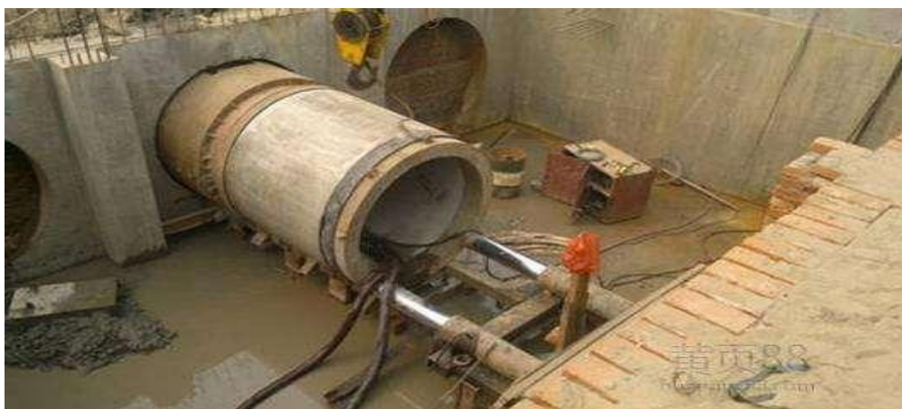
顶管施工现场图
