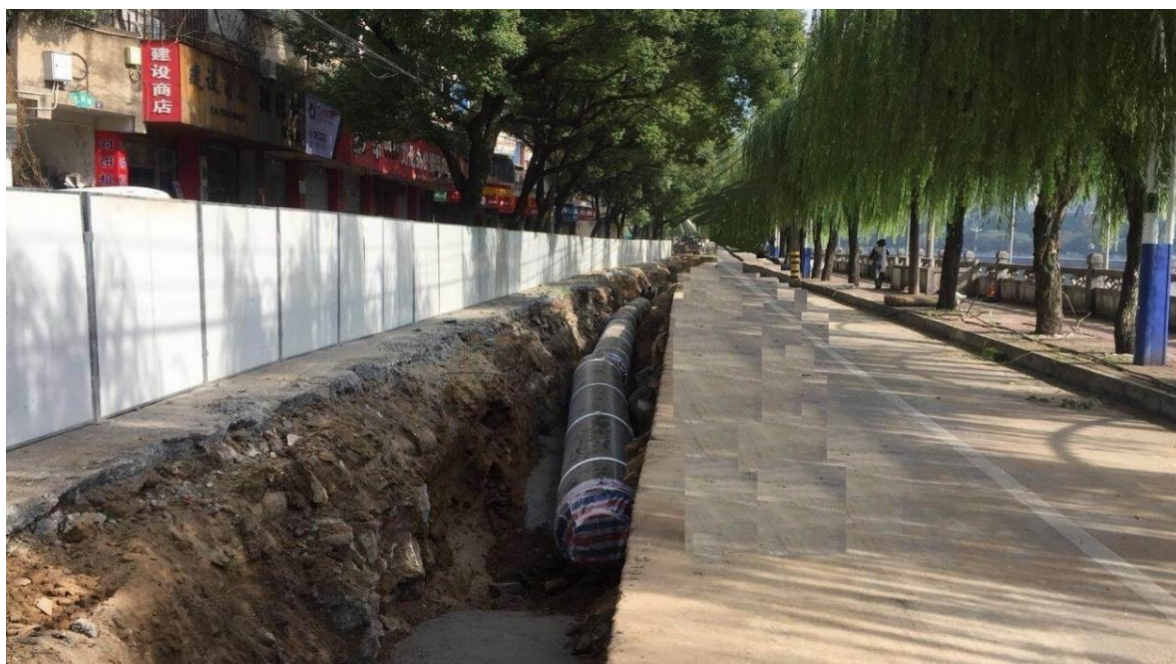
(管线沿城镇道路开挖直埋敷设实例图)
