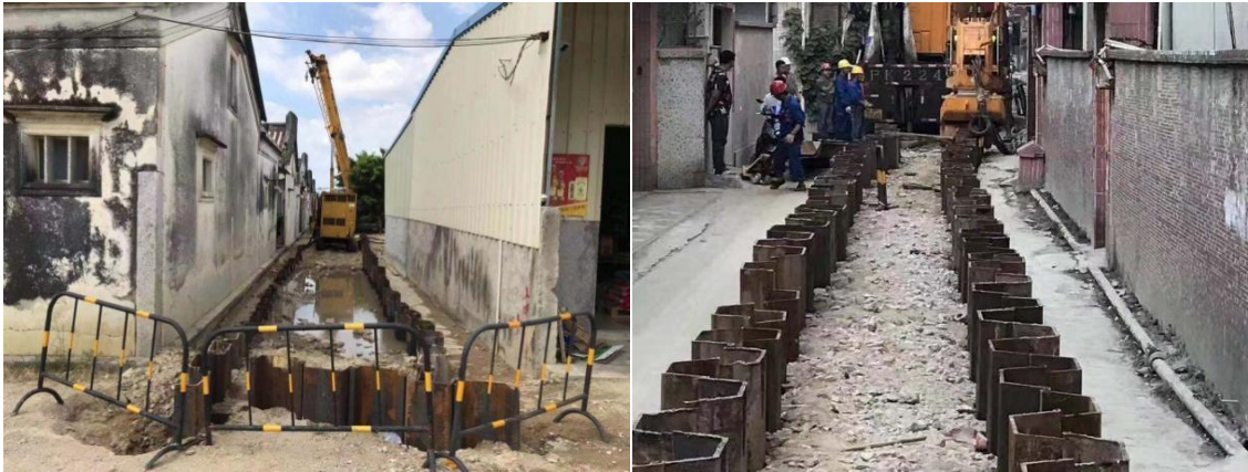
图 5.2-51 静压钢板桩施工案例
