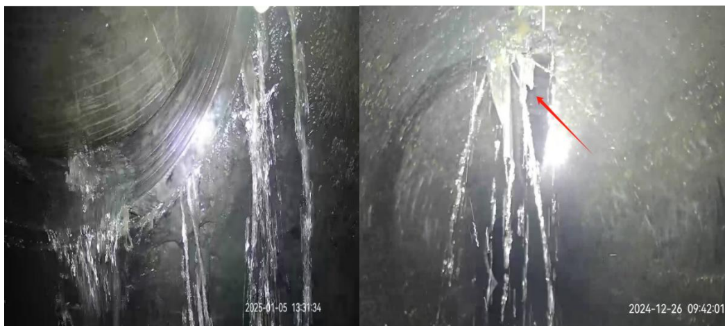
图 3.1-8 河中管渗漏问题
