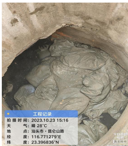
图 2.1-20 接驳点封堵现场照片
