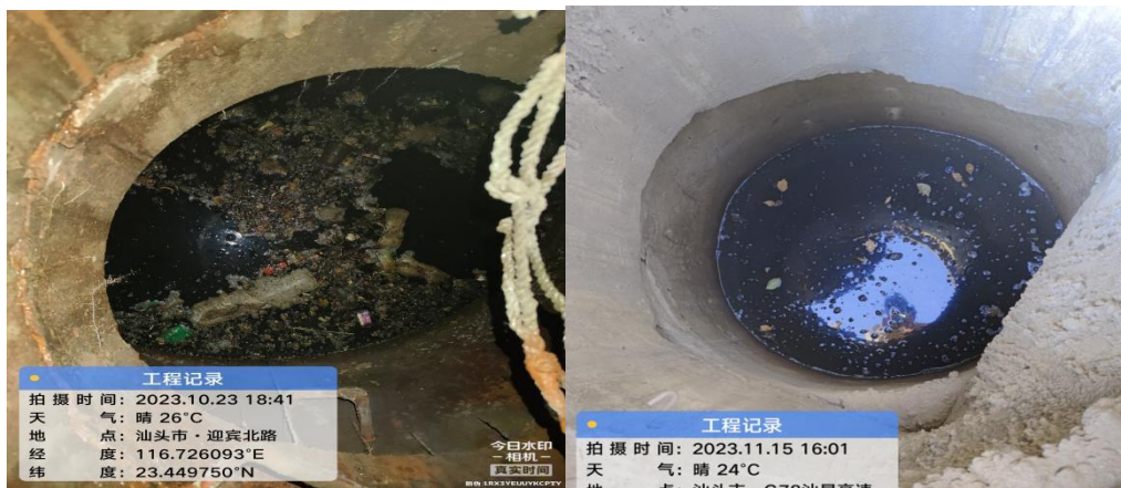
图 2.1-16 污水干管高水位运行图
