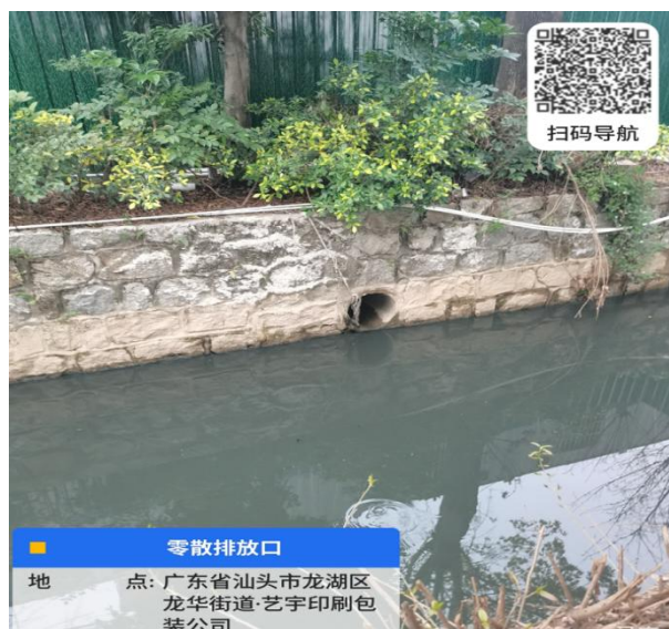
图 2.1-23 零散排水单元排口现场照片
