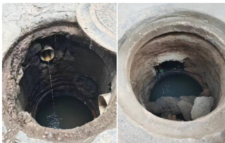
图 2.1-24 错混接点现场照片
