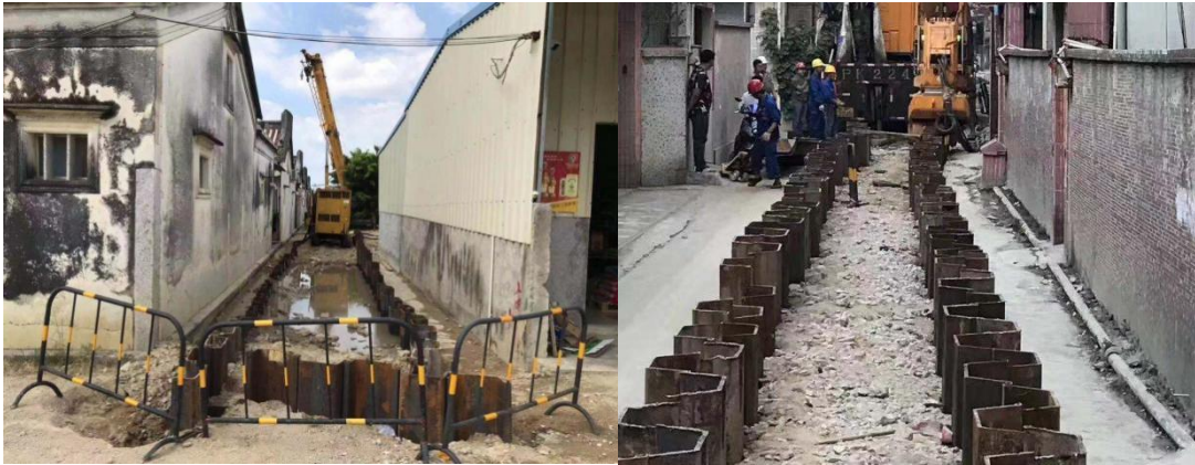
图 5.11-2 静压钢板桩施工案例
