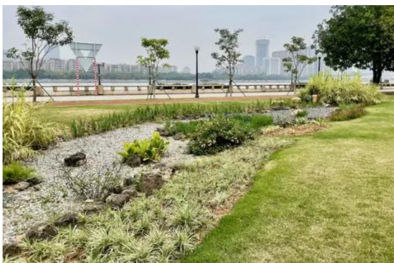
图 43 下凹式绿地示例图 1
