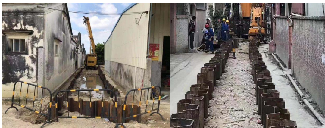
图 28 静压钢板桩施工案例
