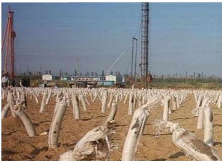
图 21 袋装砂井（或塑料排水板）及预压处理
