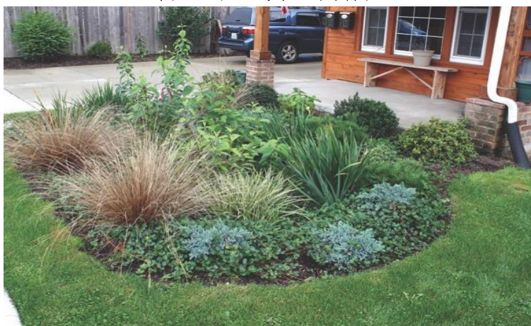
图 44 下凹式绿地示例图 2
