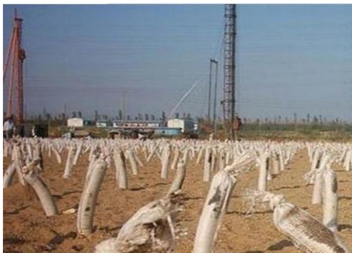
图 29 袋装砂井（或塑料排水板）及预压处理
