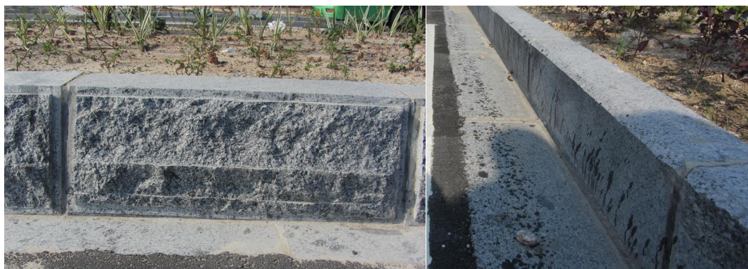
图 24 路缘石安装实景图
