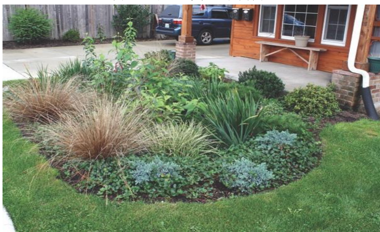
图 47 下凹式绿地示例图 2
