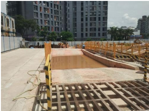
施工出入口洗车设施
