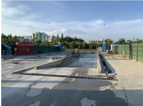
施工出入口洗车设施
