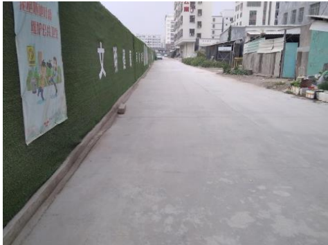
施工围挡（底部设有挡水坎）
