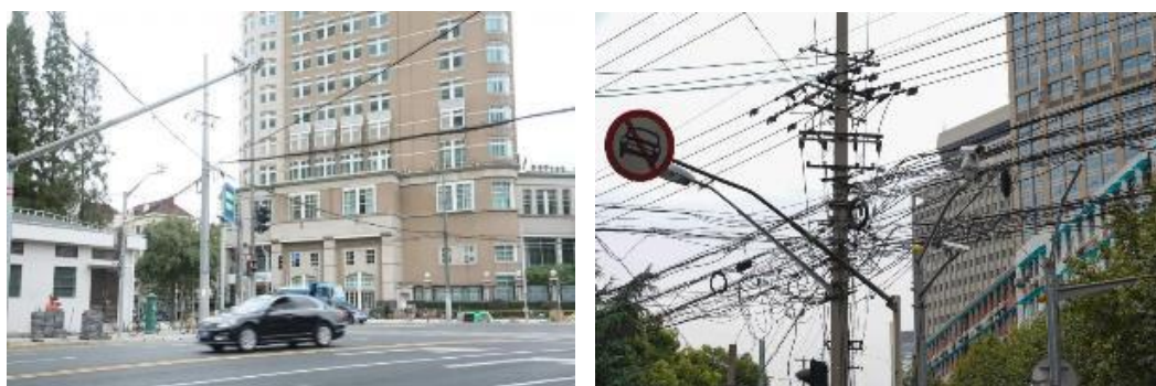
图 7-24 凌乱的杆件及架空线
