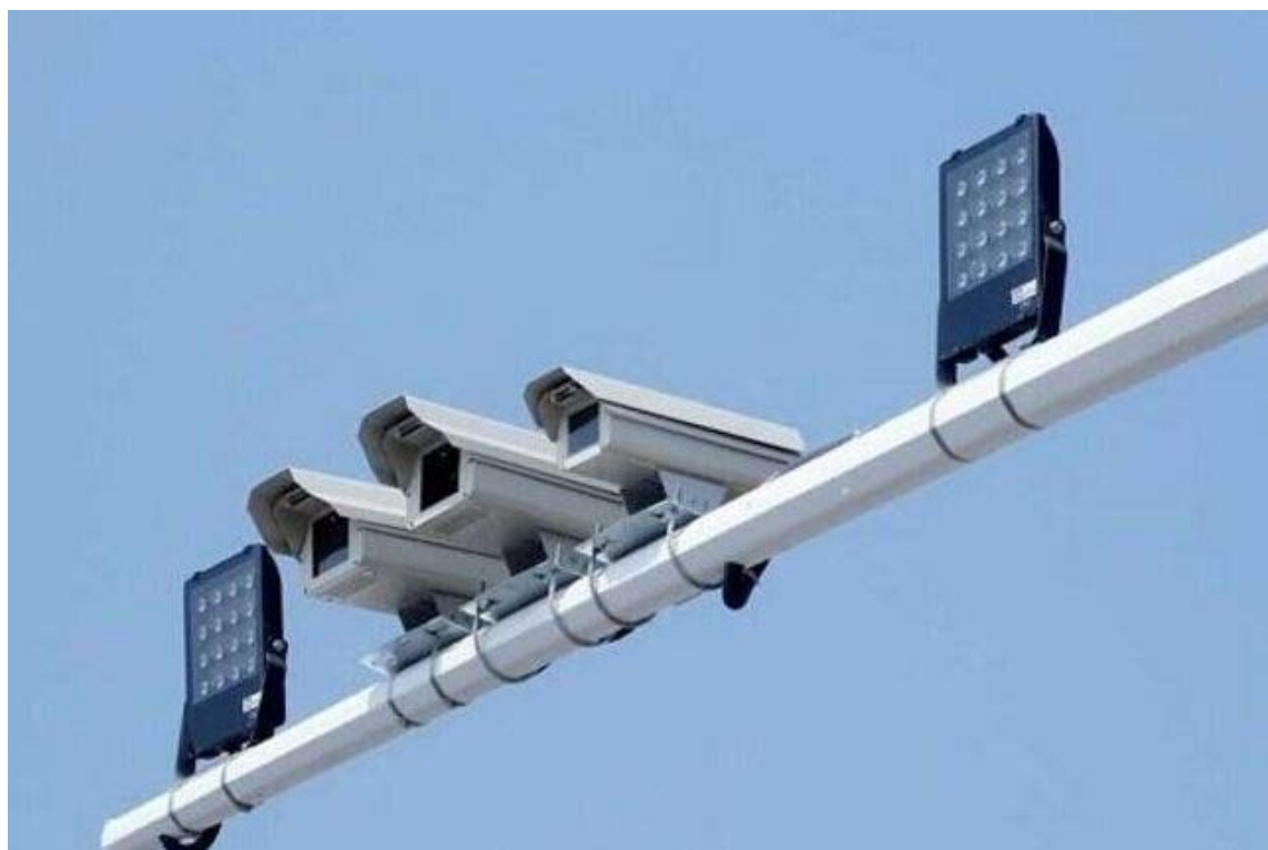
图 7-22 交通监控设施
