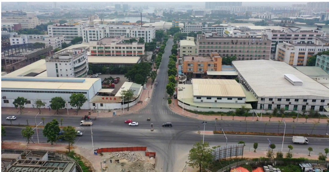
图 4-2 园区道路现状航拍图
