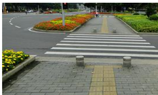
图 7-31 人行横道单面坡缘石坡道
