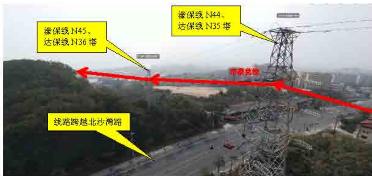
110kV 达保线 N36（濠保线 N44）架空线跨越北沙湾路
