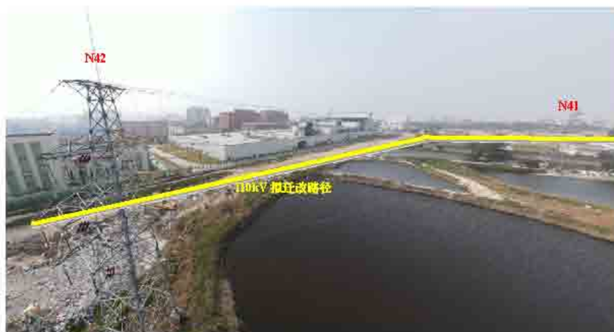
110kV 达保线 N42（濠保线 N51）周边情况
