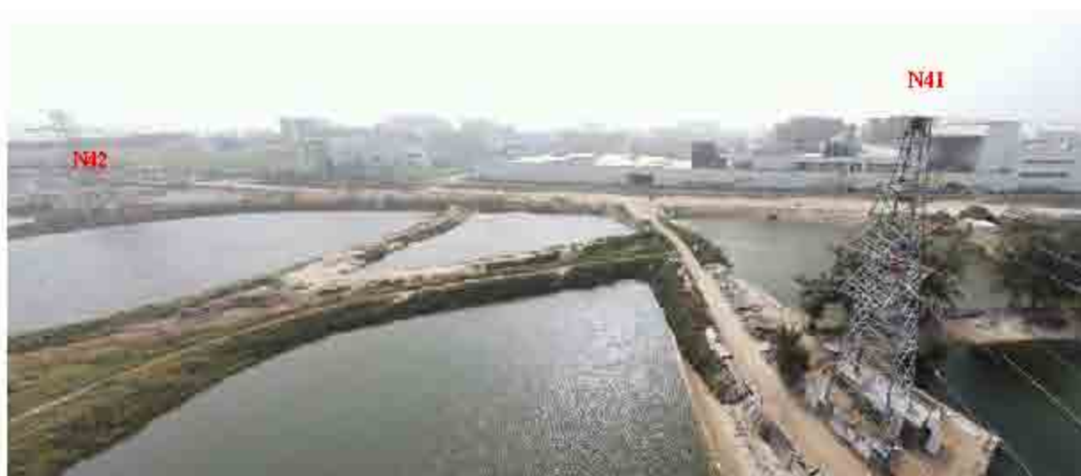
110kV 达保线 N41（濠保线 N50）周边情况
