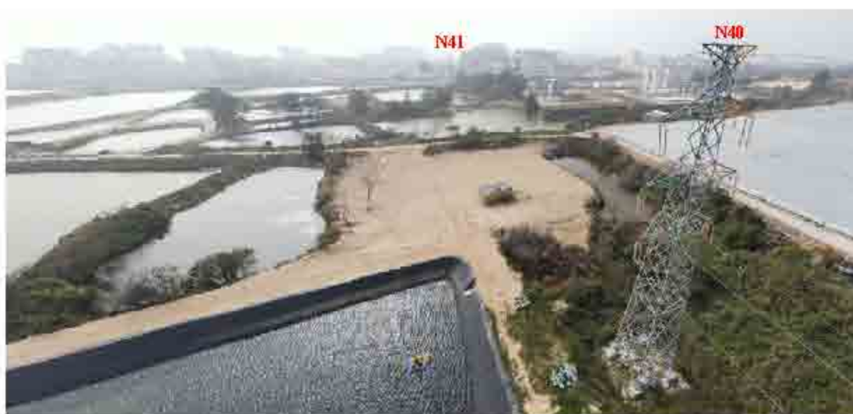
110kV 达保线 N40（濠保线 N49）周边情况
