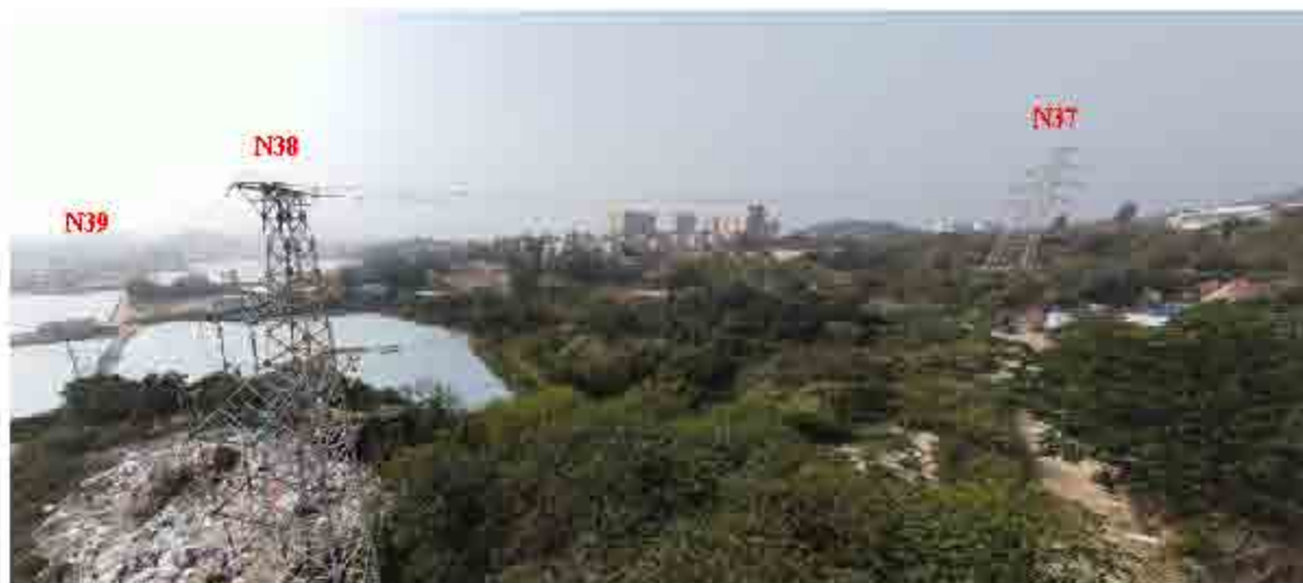
110kV 达保线 N38（濠保线 N47）周边情况
