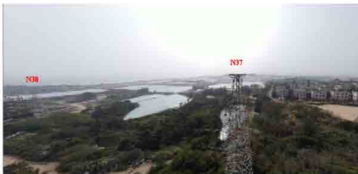
110kV 达保线 N37（濠保线 N46）周边情况
