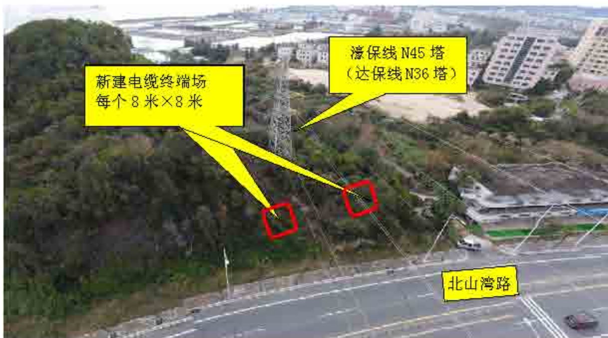
拟建电缆终端场航拍图
