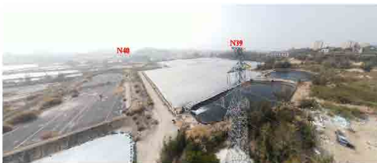
110kV 达保线 N39（濠保线 N48）周边情况
