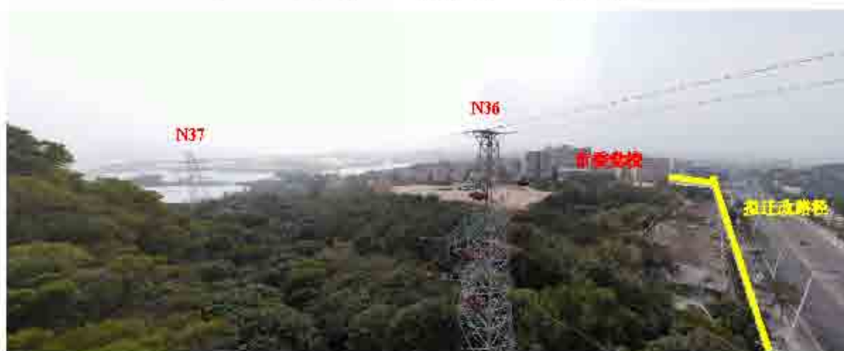
110kV 达保线 N36（濠保线 N44）周边情况
