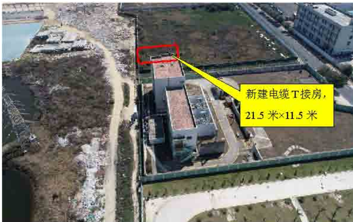
110kV 保税变电站东侧电缆 T 接房航拍图
