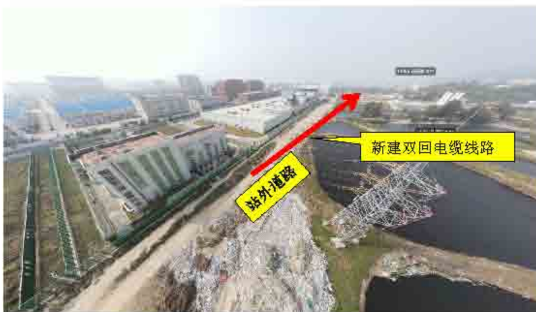
站外道路电缆走向航拍图
