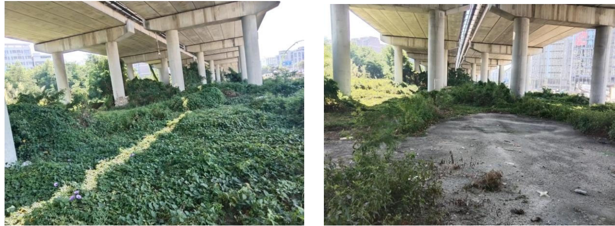
图 2-1 汕汾高速桥下现状
