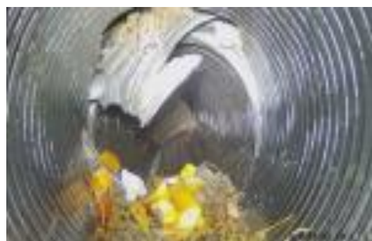
管道破裂
