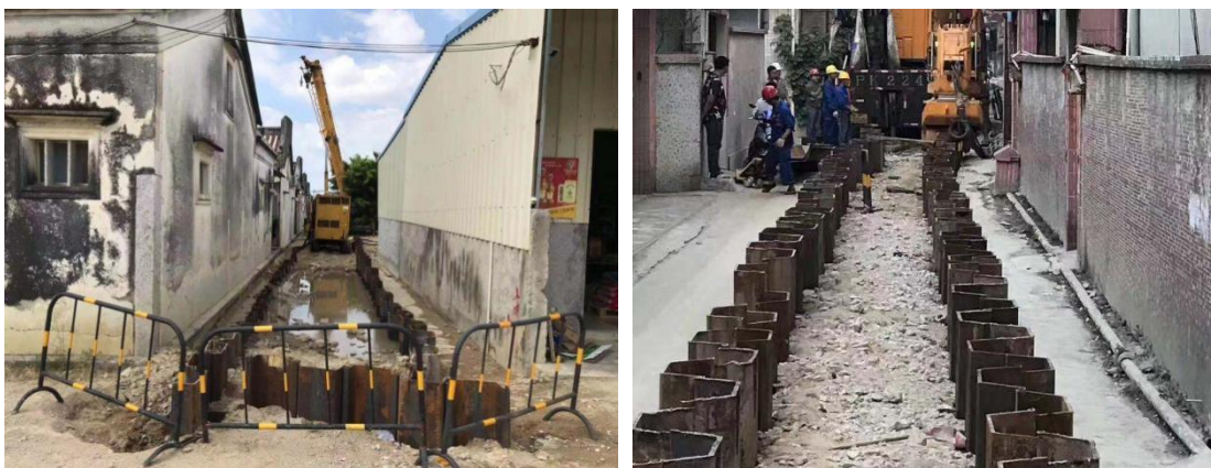
图 7.1-6 静压钢板桩施工案例
