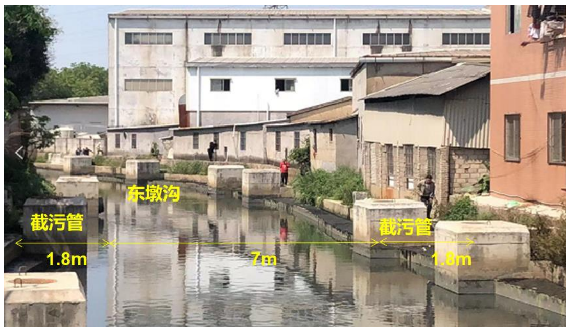
图 7.4-2 现状东墩沟排涝通道两侧截污管网图
